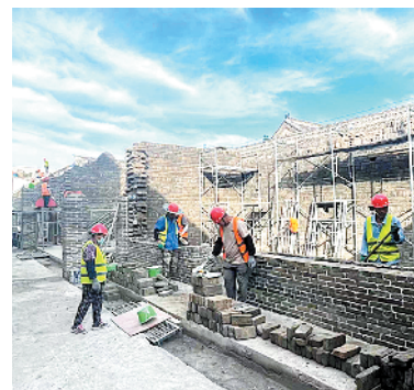
白彦章旧居项目施工现场。
