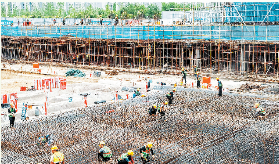
盛和便民服务中心建设施工现场
