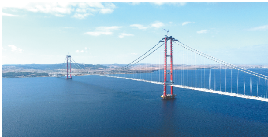
中国在土耳其参建的世界主跨最大桥梁建成通车
